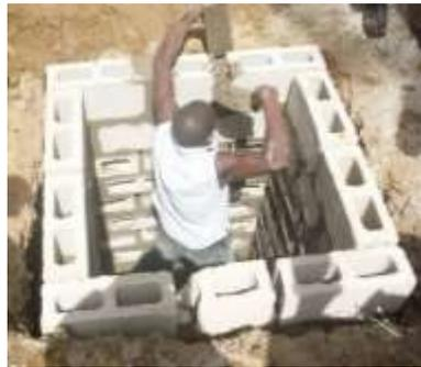
PLATE D: SHOWS NEW RECYCLED PLASTIC TOILET WALL
